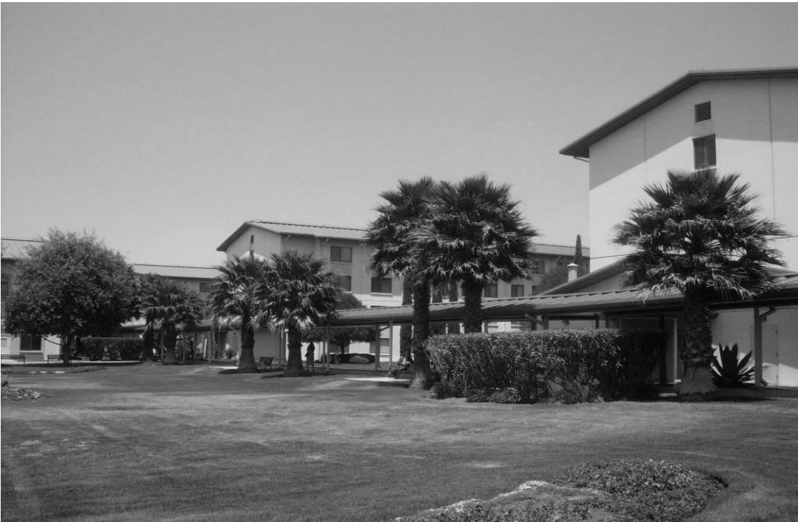
Figura 8. Instalaciones del Hogar Betel , ubicadas en el Fraccionamiento El Tejote, Texcoco, Estado de México. 2011
