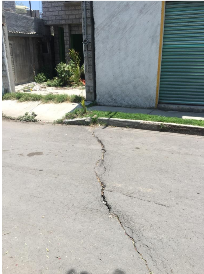
FOTO 1: CALLE DEL PUEBLO DE SANTA CATARINA, TLÁHUAC
