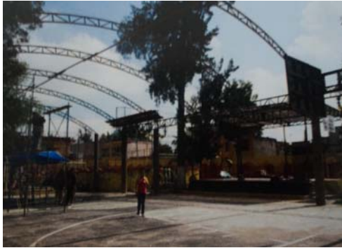
Obras de la primera parte del proyecto 2008
