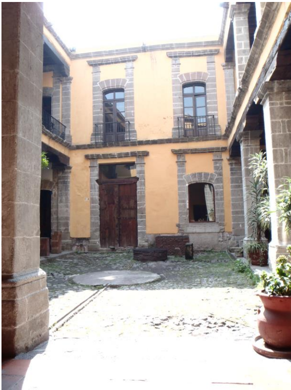
Imagen del primer patio, el cual se puede acceder por la puerta principal, actualmente se puede apreciar el rastro del pazo artesiano. Fuente: Pertenece al archivo fotográfico de nuestra investigación (2013).
