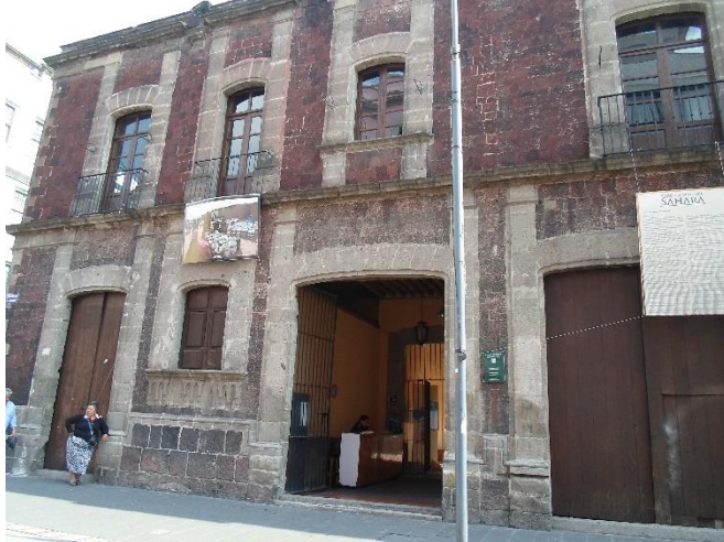
Imagen de la fachada de Casa Talavera, actualmente es el acceso para visitar el inmueble. Fuente: Pertenece al archivo fotográfico de nuestra investigación (2013).
