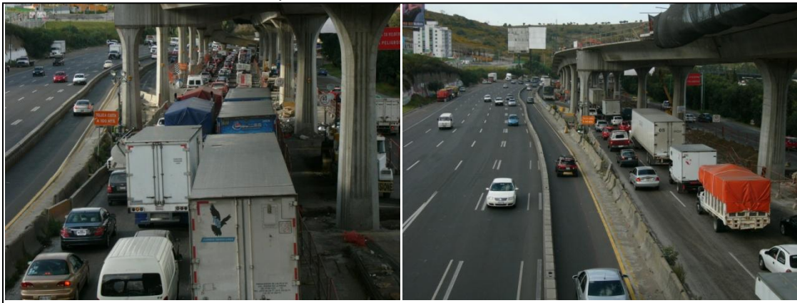
Fotos 3.4 Autopista México-Querétaro dirección Querétaro
