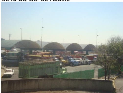
Foto 2.3 Vista de andenes de descarga de la Central de Abasto
