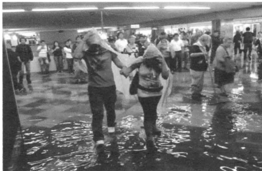
Ilustración 6.8 Encharcamientos en el sistema por goteras, [3].
