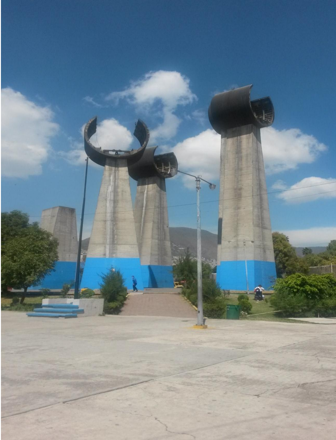
Figura 1. Monumento a túnel emisor oriente lumbrera cero dentro de la escuela Miguel Lerdo de Tejada Cetis No7.
