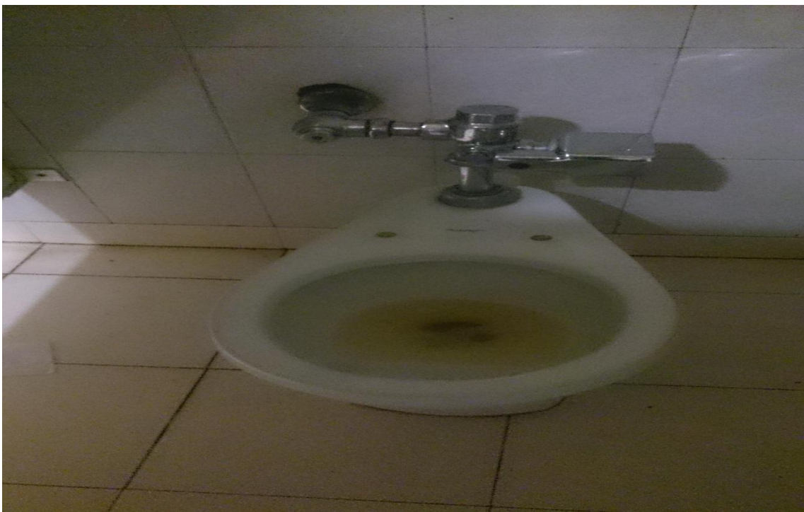
Figura. 22. Sanitario de Hombres de la escuela Miguel Lerdo de Tejada CETÍS No.7
