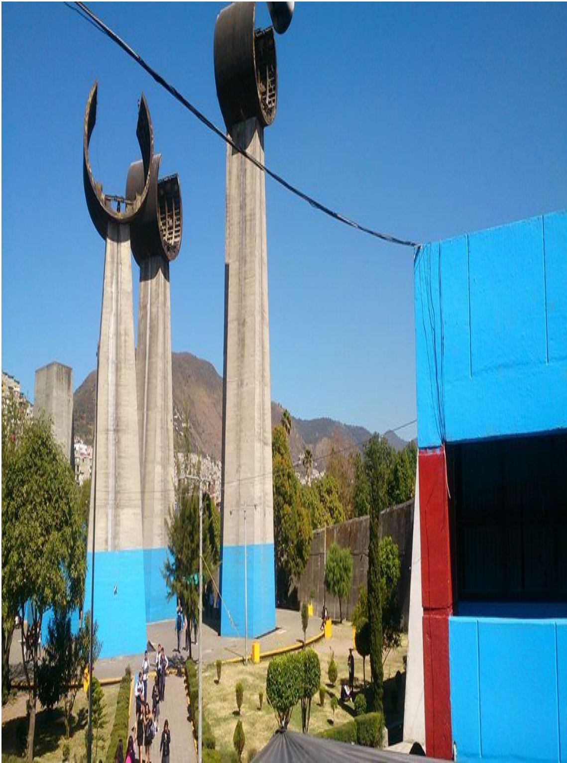
Figura 19 .Monumento a la obra del drenaje profundo lumbrera cero dentro de la escuela cetís n.7
