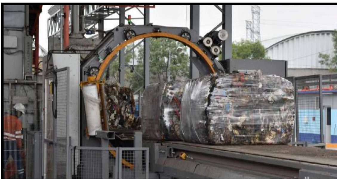
Figura I.13. Instalación de plantas de compactación.
