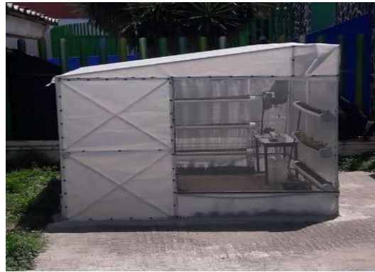
Figura 6.10: Forrado con plástico y malla de la estructura.
