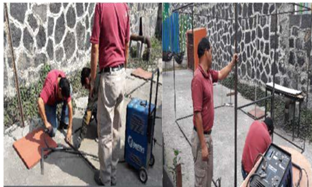
Figura 6.8: Armado de la estructura.
