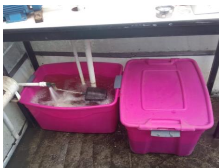
Figura 3.4: Sistema de almacenamiento de agua.
