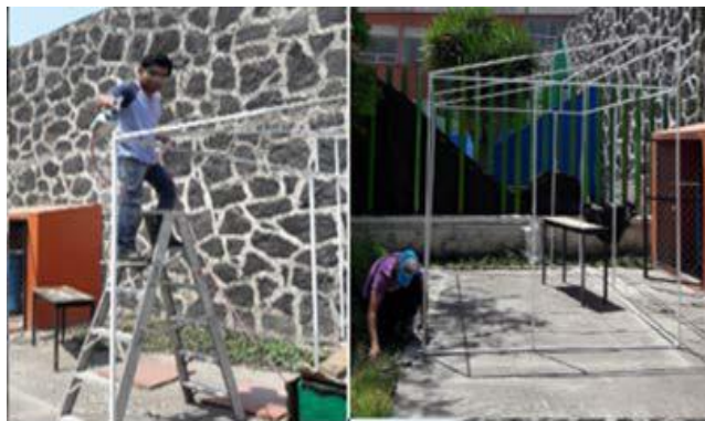
Figura 6.9: Pintura base y pintado de la estructura.
