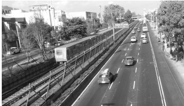
Figura 31. Derecho de Vía Tipo A. Metro de CDMX.
