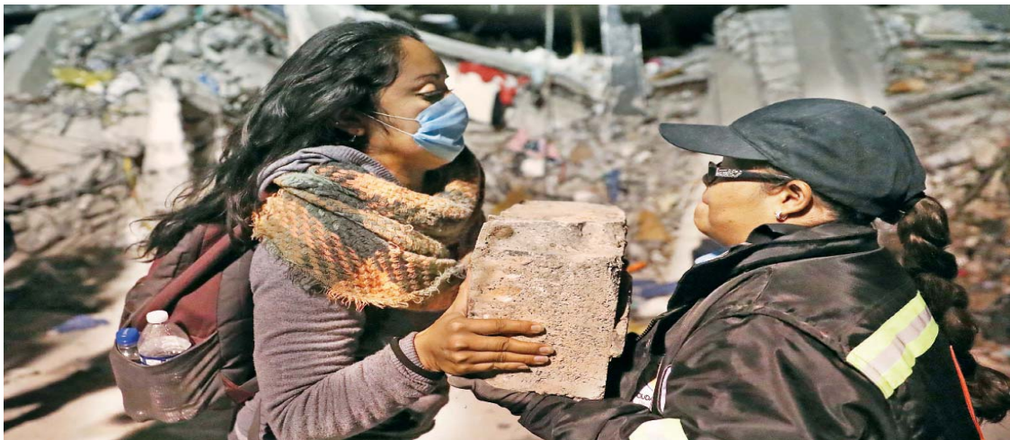
FUERZA. Día y noche integrantes de cuerpos de emergencia y ciudadanos apoyan con sus manos las labores de rescate entre los escombros de edificios colapsados en la Ciudad de México.
