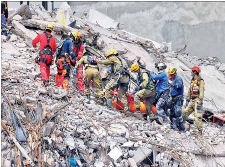
Los cuerpos de rescate finalmente lograron sacar ayer el cadáver de Éric Gaona, quien quedó atrapado en el derrumbe del edificio ubicado en Medellín, esquina con San Luis Potosí, en la colonia Roma ■ Foto Marco Peláez
