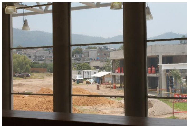
Figura 8. Obra en construcción del campus Cuauhtepac
