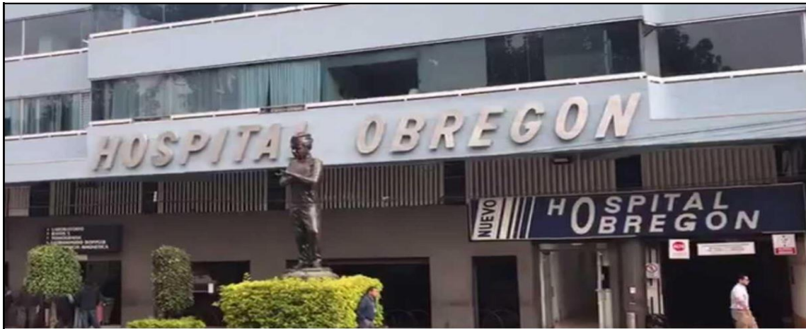
Figura 11. Fachada principal del Hospital Álvaro Obregón
