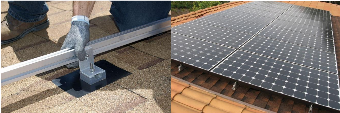
Ilustración 34 Ejemplos de estructura coplanar. Fuente: Proveedor http://www.plpmexico.com
