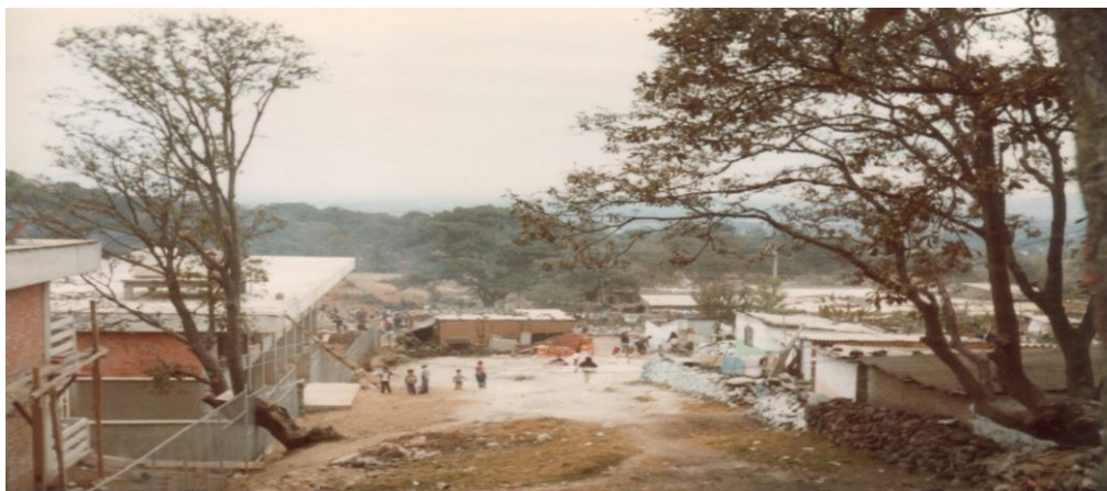
Figura 20. Se observa las condiciones del terreno y las incipientes casas apenas se dibujan. La fotografía muestra el cruce de las ahora calles de Miramontes y Loma Bonita, al fondo puede apreciarse la total ausencia de edificaciones 1980. (Fotografía del señor Lozada 2021)
