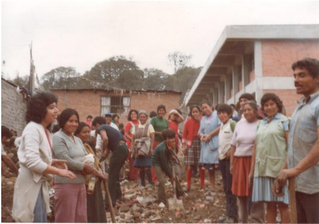
Figura 25. Construcción de la escuela primaria (Fotografía proporcionada por el Sr. Guerrero en el año 2021)
