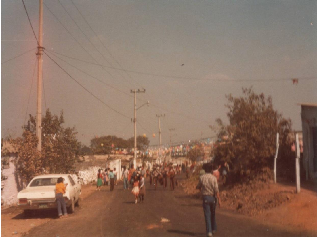
Figura 21. Av. Cantera, ya pavimentada. San Juan Tepeximilpa 1980. (Fotografía proporcionada por el señor Soto en el año 2021)
