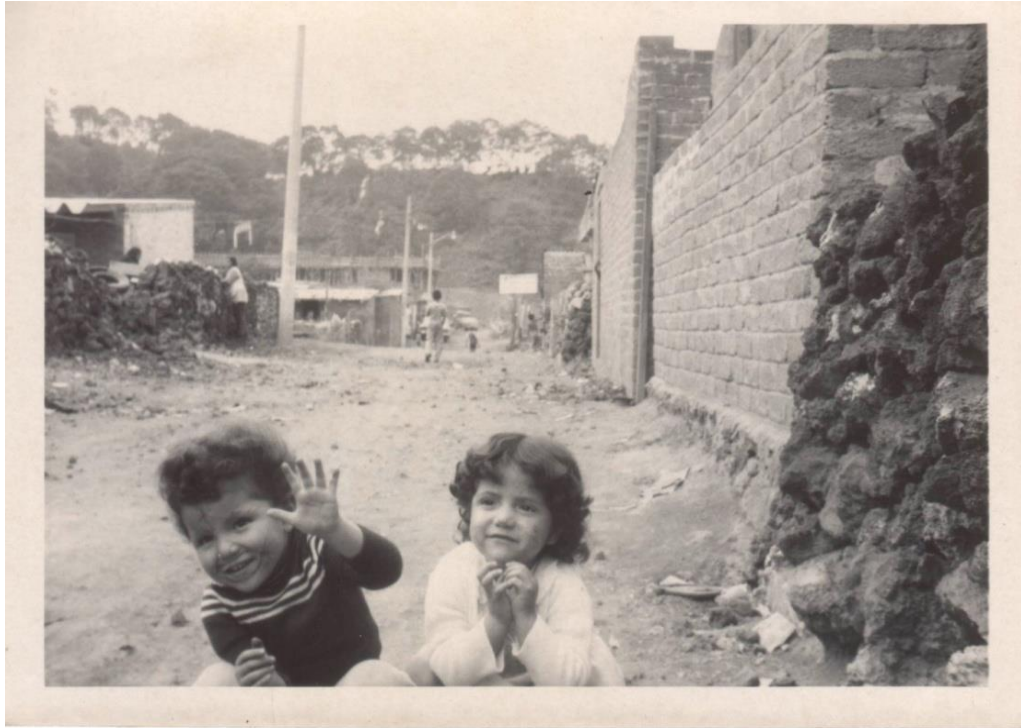
Figura 22. Calle Camelia esquina con Cantera, ya con alumbrado público. Al fondo, puede observarse el camino en subida, entre árboles, hacia la actual Ampliación Tepeximilpa SERVIMET. (Fotografía proporcionada por el señor Soto en el año 2021)
