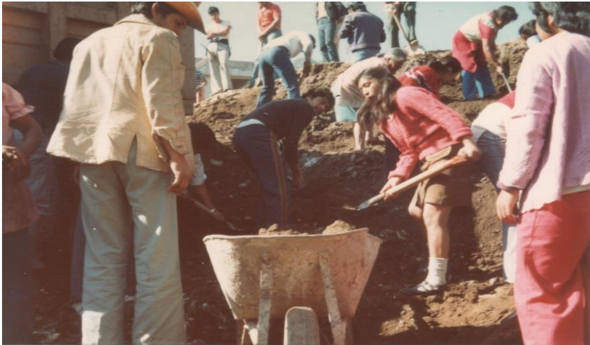
Figuras 23 y 24. Muestran las faenas de los colonos en la construcción de la escuela primaria ubicada en la esquina de las calles de Loma Bonita y Camelia. Los habitantes de la casa que se observa al fondo fueron reubicados al realizarse el reacomodo en Ampliación Tepeximilpa-SERVIMET (1980), para dejar la calle libre y fuera la entrada de la escuela. (Fotografía proporcionada por el señor Guerrero en el año 2021)
