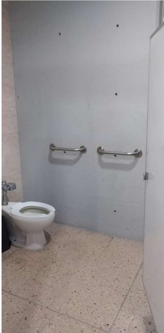
Barras de agarre en sanitarios para personas con discapacidad. Cuautepec.
