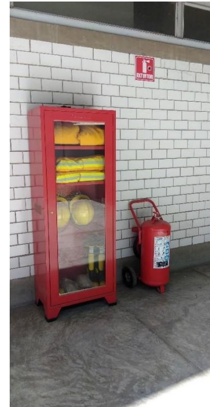
Extintor de CO2 y Gabinete con equipo de protección personal. San Lorenzo Tezonco.
