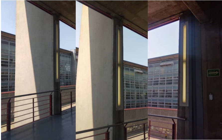
Fotografía 6 Columnas en edificios para alumnos. Plantel San Lorenzo Tezonco.
