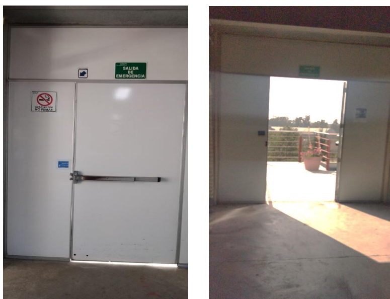
Fotografía 3. Salidas de emergencia bien definidas y señalizadas.
