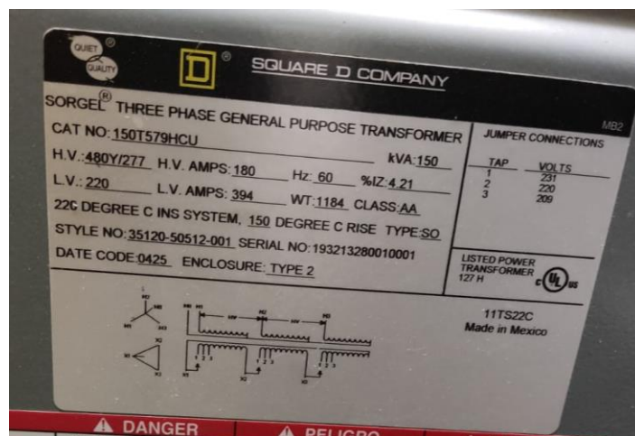
Figura 15. Datos del transformador elevador (220 V a 480 V), que alimenta al tablero de alumbrado, edificio A Fuente: Elaboración propia
