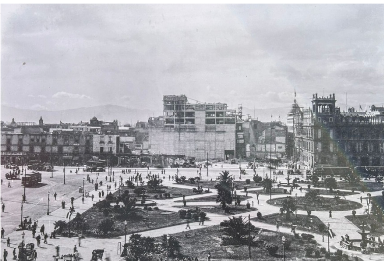
Inicio de obras de construcción de nuevo Palacio del Ayuntamiento y Av. 20 de Noviembre, vista desde la Catedral, 1935.
