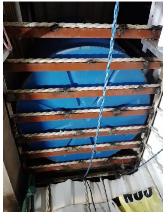
Figura 29. Soporte reforzado para tinaco de 450 litros.
