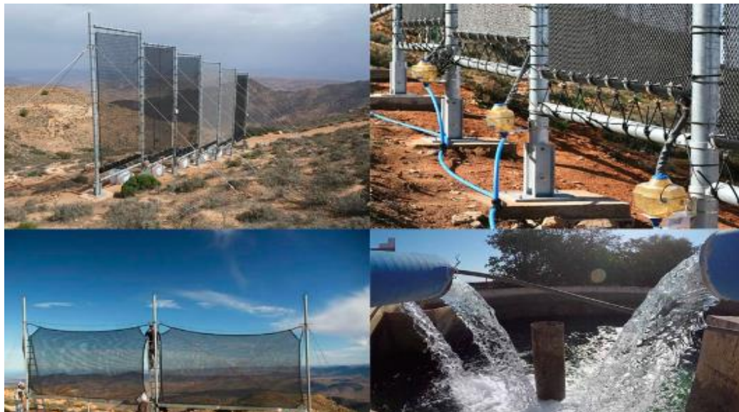
Figura 22. Aplicación de la tecnología CloudFisher en Monte Boutmezguida
