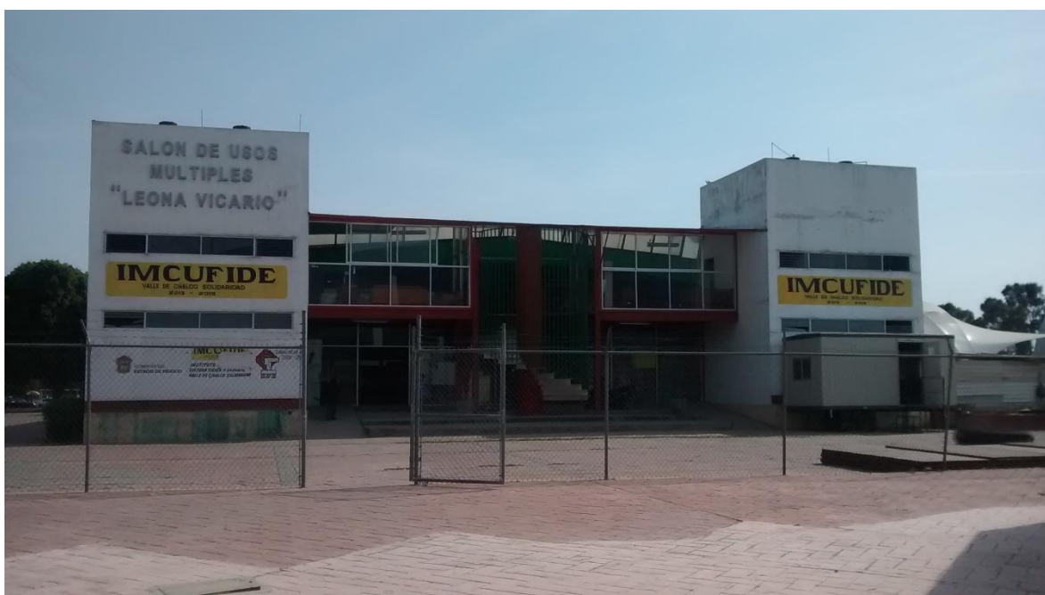
Figura 1. Fuente: Elaboración propia. Ubicación temporal de la Casa de Cultura por remodelación, en el salón de usos múltiples Leona Vicario localizado a un costado de la entrada principal del deportivo Luis Donaldo Colosio .
