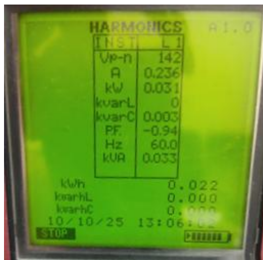
Figura 5.59 Condiciones de entrada al driver a 142V con analizador de red eléctrica.
