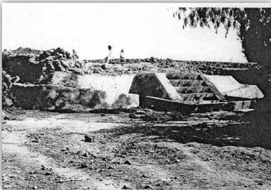
Basamento piramidal, ubicado en la Presa Anzaldo, previo a cubrirlo con aguas negras.
