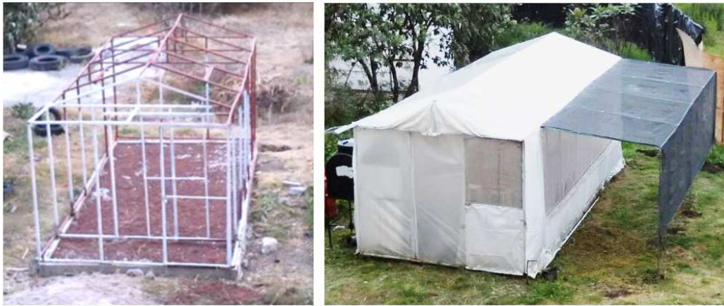
Figura 3.1: Estructura metálica e invernadero terminado.
