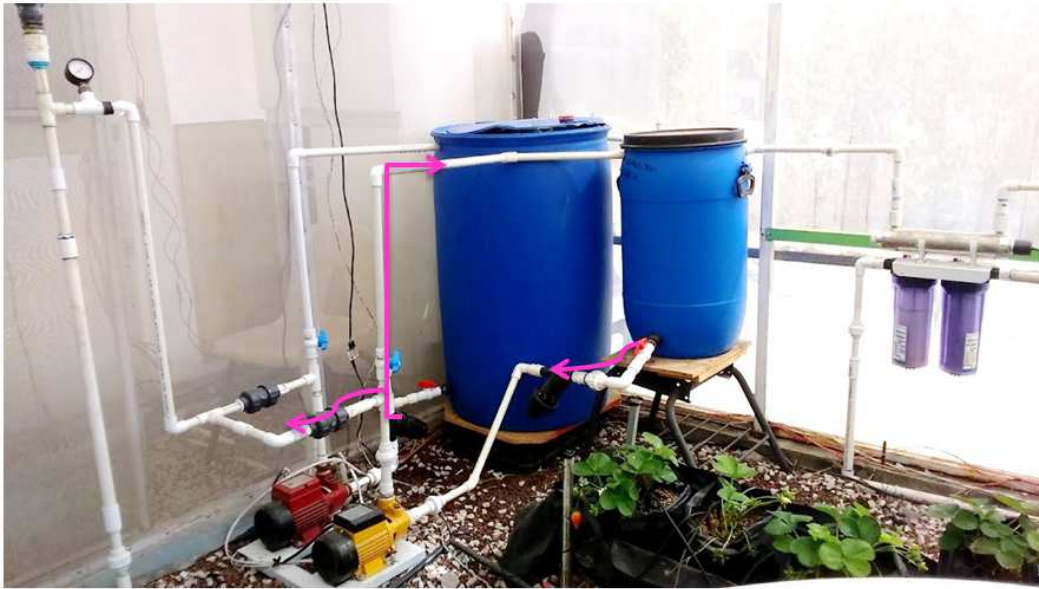
Figura 3.4: Distribución hidráulica. El tanque del lado izquierdo de la figura contiene agua simple, el tanque del lado derecho, solución nutritiva.
