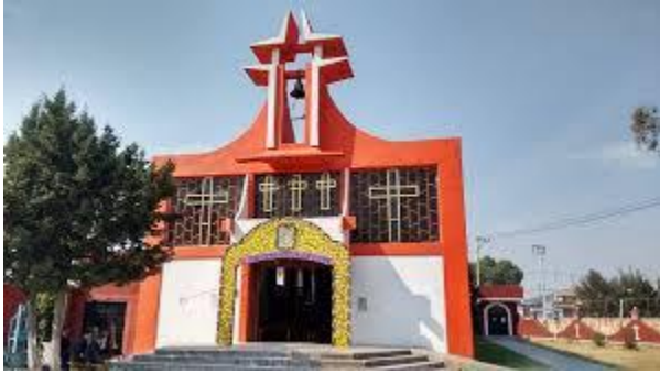
Iglesia de san Sebastián Tecoloxtitlan actualmente
