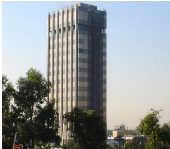
Figura II.4 Torre principal del complejo de edificios que integran el campus del Instituto Mexicano de Petróleos en la Ciudad de México
