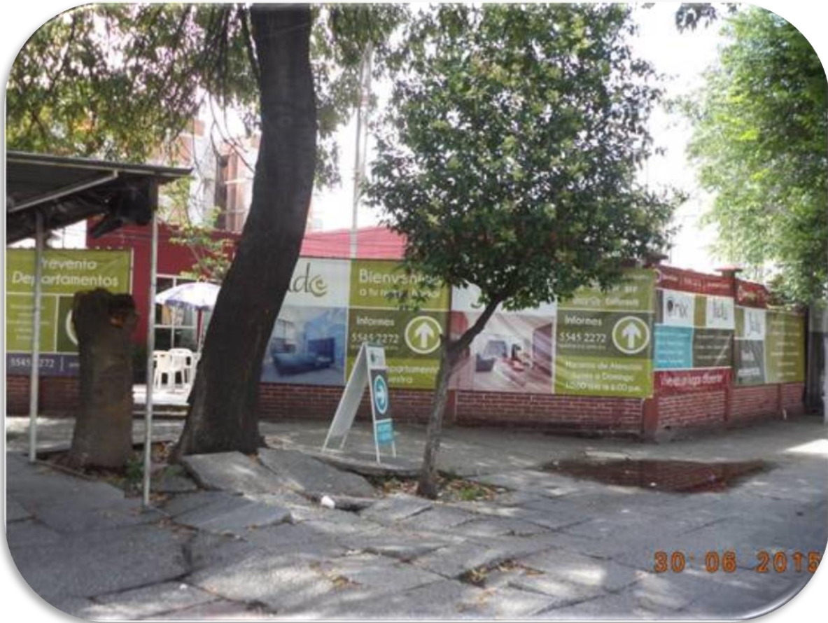
Fotografía 14. Año 2015. Terreno en construcción. Autoría propia.
