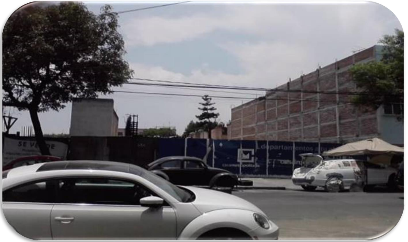
Fotografía 11. Año 2014. Terreno en construcción. Autoría propia.
