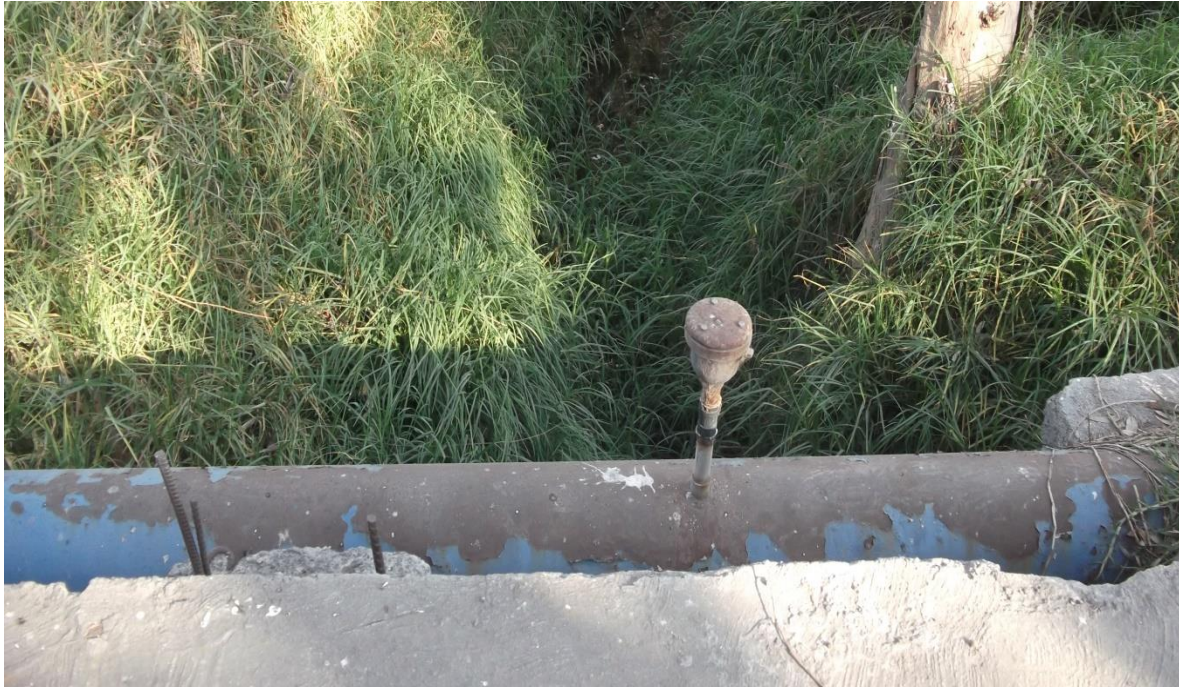
Paulin, L. (2014) ejidos de Ixtayopan F11 Foto de una toma de agua que sirve en el sistema de riego de los ejidos
