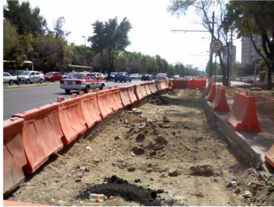
Figura 4.35: Imagen 33 Paseo de la Reforma - eje 2 norte Canal del Norte.
