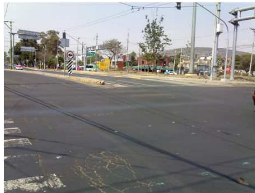
Figura 4.41: Imagen 38 eje 3 norte avenida Ingeniero Eduardo Molina - eje 5 norte Calzada San Juan de Aragón.
