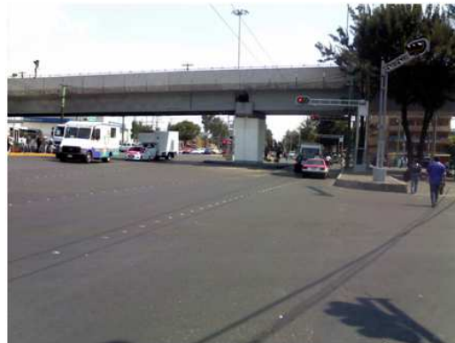
Figura 4.9: Imagen 7 eje 1 oriente Ferrocarril de Hidalgo - eje 5 norte Calzada San Juan de Aragón.
