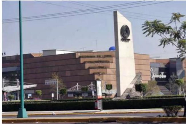
Figura 3.2 Tipos de estacionamiento ubicados fuera de la calle (Tlalpan). estacionamiento Centro Comercial Perisur. Fuente propia 2016.
