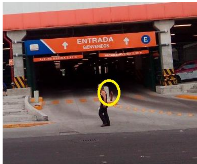
Figura 5.3. Entrada con espacio adecuado para la colocación de plumas de entrada. Fuente: Elaboración propia 2016.
