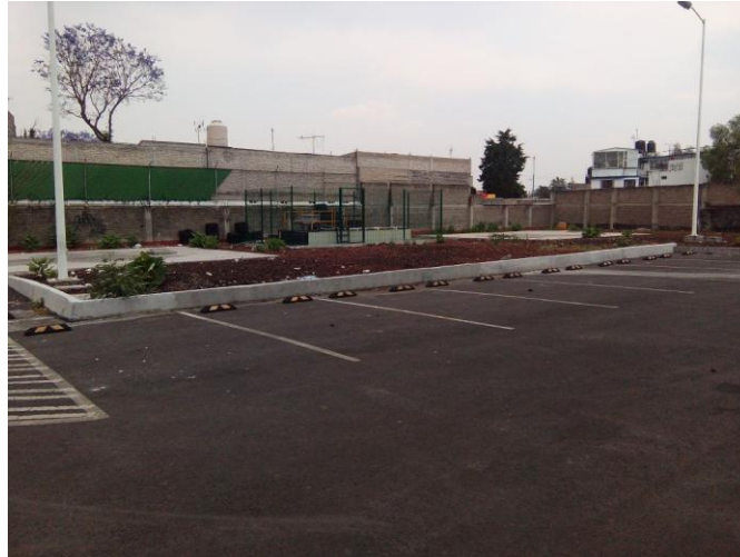
Figura 5.2. Señalización adecuada y marcas de cajones para vehículos. Fuente: Elaboración propia 2016.
