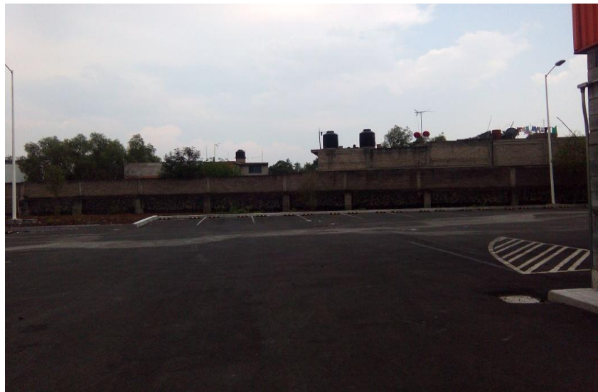
Figura 3.11 Tipos de estacionamiento ubicados fuera de la calle (Coyoacan). estacionamiento Chedrahui Pedro Henriquez Ureña. Fuente propia 2016.
