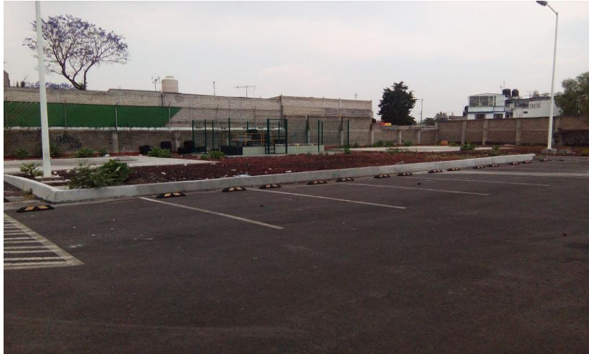
Figura 3.12 Tipos de estacionamiento ubicados fuera de la calle (Coyoacan). estacionamiento Chedrahui Pedro Henriquez Ureña. Fuente propia 2016.
