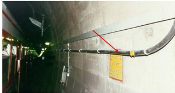
Figura 31 Cable radiante
