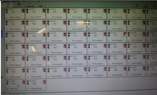
Foto 8 Señal emitida por parte del tren y que se registra en el monitor de telefonía Tetra instalado en el pupitre del tablero de Línea 8 en PCC
