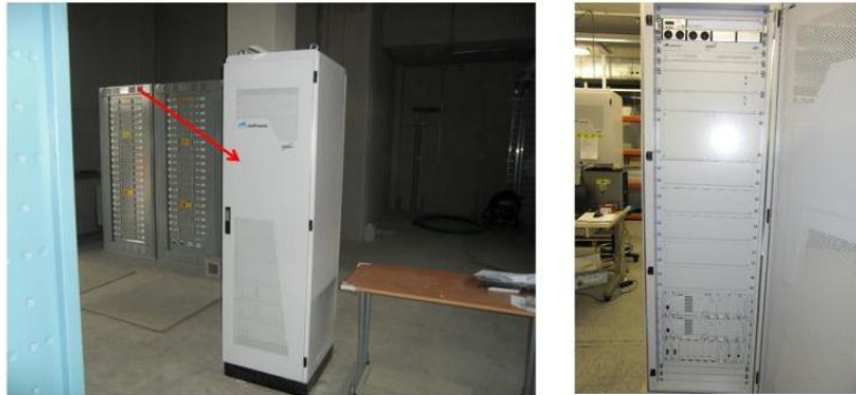
Figura 30 Armarios de Estación Base
