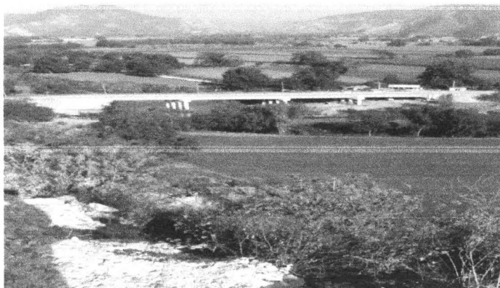
Foto. 15. Fuente: Foto del puente de Salinas Cruz cuando ya fue reparado. Tomada por Areli Castillo y Leticia Olvera. Enero, 2012.
