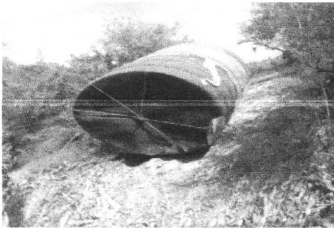
Foto. 14. Fuente: Foto que representa el levantamiento del tinaco que va a servir para abastecer y almacenar el agua al sistema de distribución hidráulico. Tomada por Areli Castillo y Leticia Olvera. Enero, 2012.
