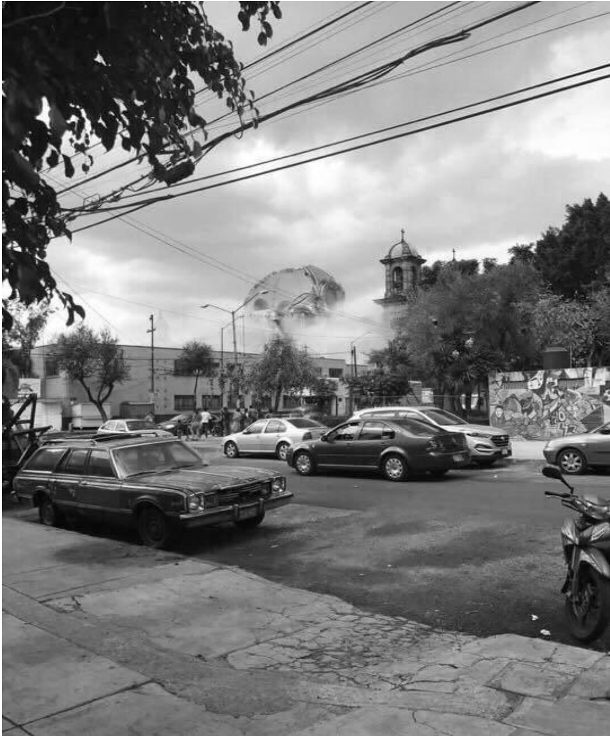
Colapso de la cúpula de la Parroquia Nuestra Señora de los Ángeles, en el sismo del 19 de septiembre del 2017. Foto de: endirecto.mx
